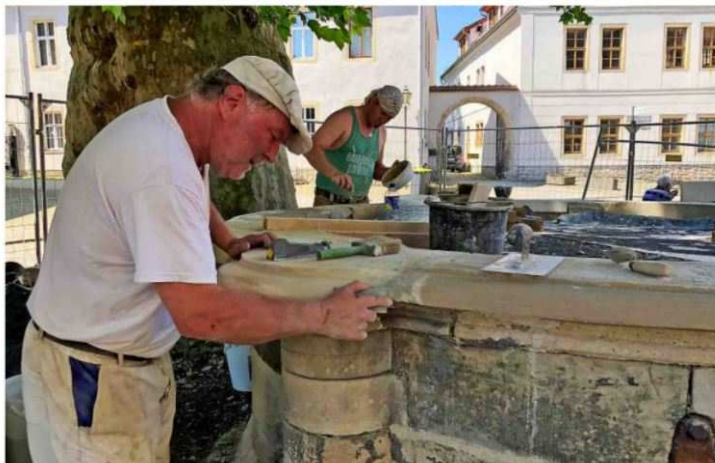
Die beiden Steinmetze und Steinbildhauer Ulrich Janku (l.) und Marcel Kleinschmidt arbeiten an dem im Jahr 1515 errichteten Brunnen auf dem Domplatz. Sie ersetzen fehlende Steine und beheben andere Fehlstellen. FOTOS: UNDINE FREYBERG
