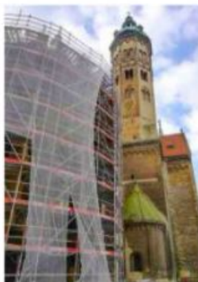
Die Fassade des Naumburger Doms wurde 2020 saniert. FOTO: MEINHARDT
