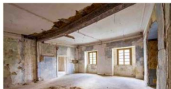
In der früheren Wohnung des Bischofs Julius von Pflug sind noch Holzbalken und Putze aus dem 16. Jahrhundert erhalten geblieben.
